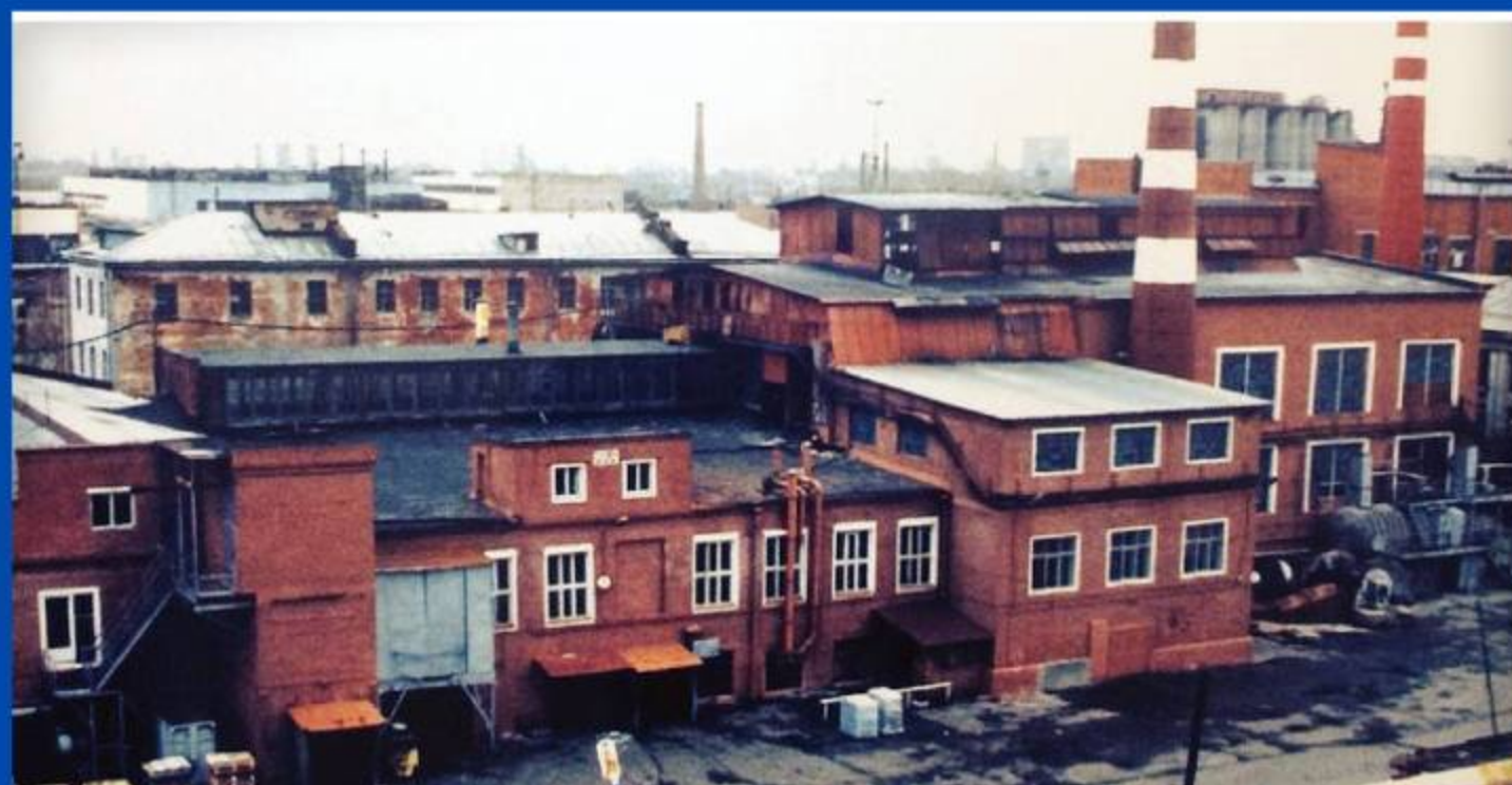
Здание бывшего хрустального завода на Бутырке, известного как «Флакон» Фотография 2008 года
