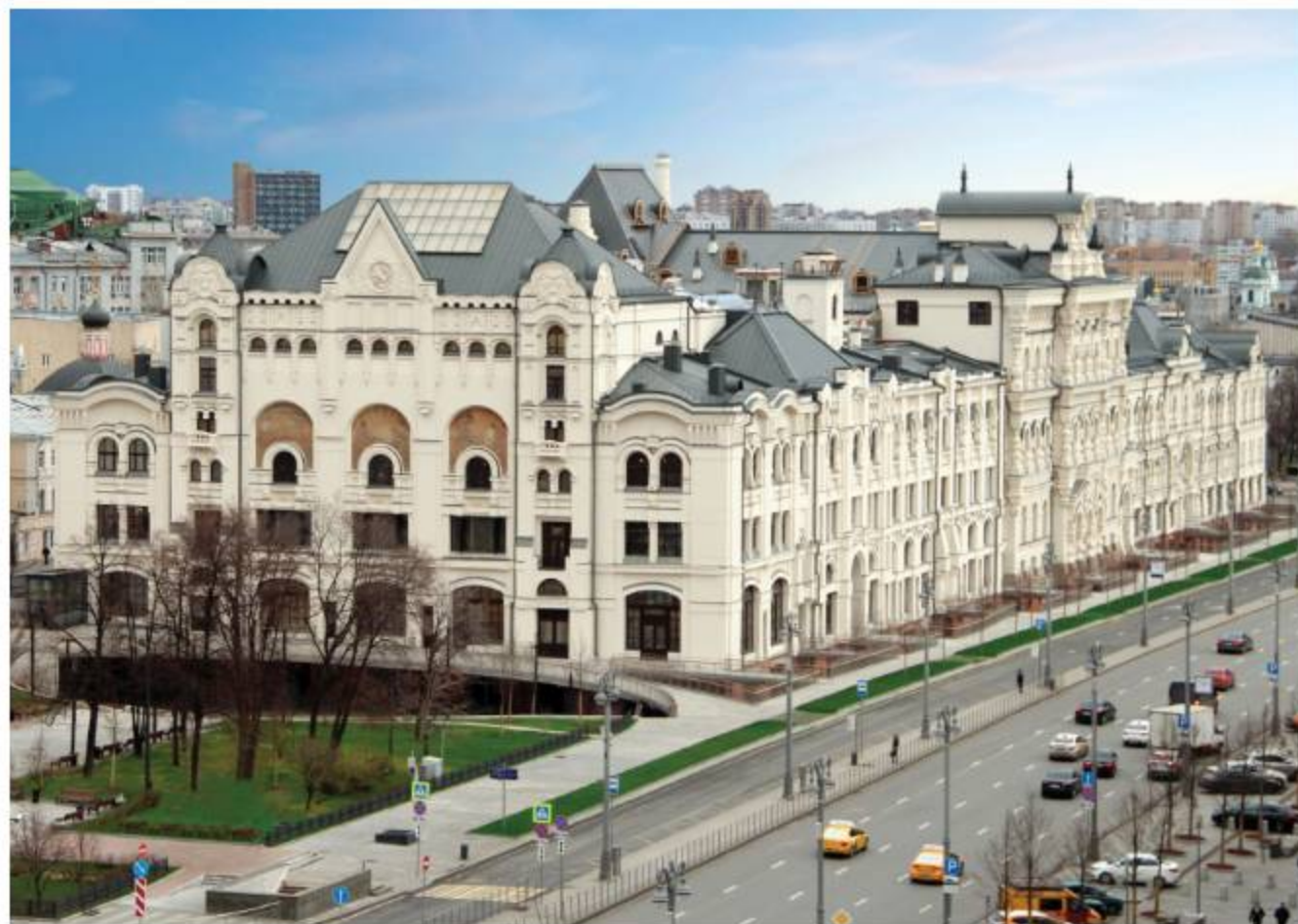
Здание Политехнического музея. На реконструкции с 2013 года
