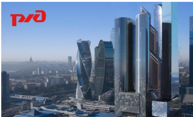
Moscow Towers · РЖД 263 тыс. кв. м офисов · Класс А М М М D4 м. Москва-Сити
